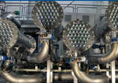
Nitrosamine lassen sich mit keinem der bekannten Aufbereitungsgverfahren wirtschaftlich aus dem Wasser entfernen. PWT Wasser- und Abwasser-technik GmbH hat daher eine neue Technologie für die Entfernung von Nitrosaminen aus Wasser auf Basis der UV-Technik entwickelt und erfolgreich in der Praxis getestet. Die UV-Anlagen der PWT sind vollständig aus Edelstahl gefertigt. Sie sind vollautomatisiert und mit kontinuierlich arbeitender Funktionsüberwachung ausgerüstet.
