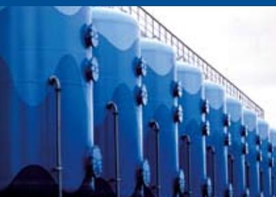
Über Entnahmestellen wird das so vorgereinigte Wasser als angereichertes Grundwasser entnommen und zur Trinkwasseraufbereitungsanlage Halle-Beesen gepumpt. Nach erneuter Belüftung wird das geförderte Grundwasser über Mehrschichtfilter von Trübstoffen, Eisen und Mangan befreit und anschließend mit Ozon behandelt. Eine abschließende Filtration über Aktivkohle entfernt noch vorhandene Mikroverunreinigungen und überschüssiges Ozon.
